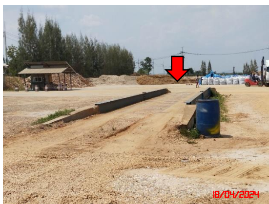
รูปที่ 13 จุดขังน้ำหนักรถบรรทุก
